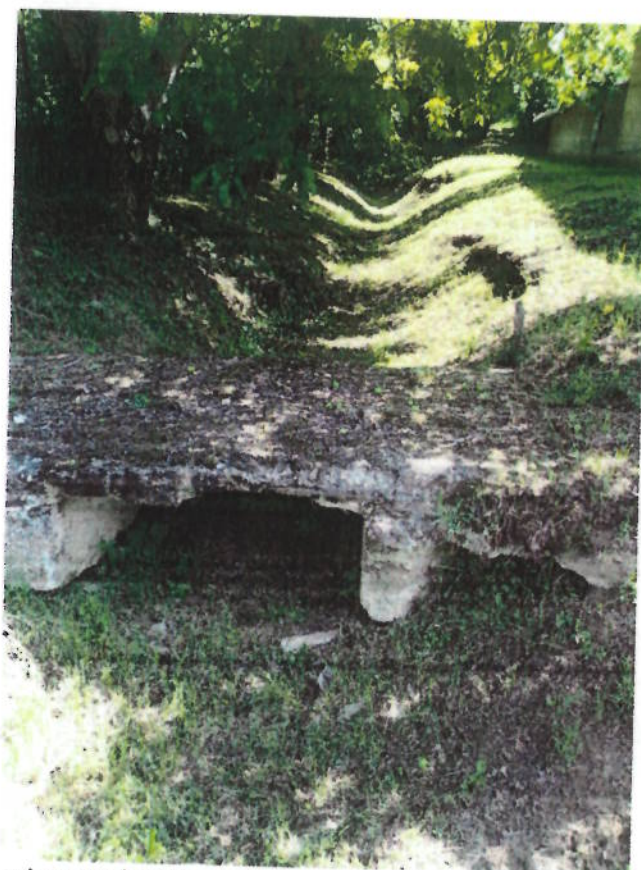
Obr. 7. Jarok pre odvádzanie povrchového odtoku z intravilánu, ktorý býva často celkom zanesený
