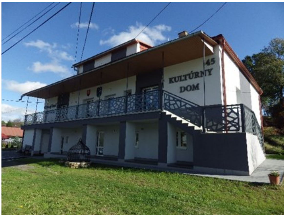
Foto č. 1–Pohľad na modernizované kultúrno-správne zariadenie Obecného úradu v Radome
