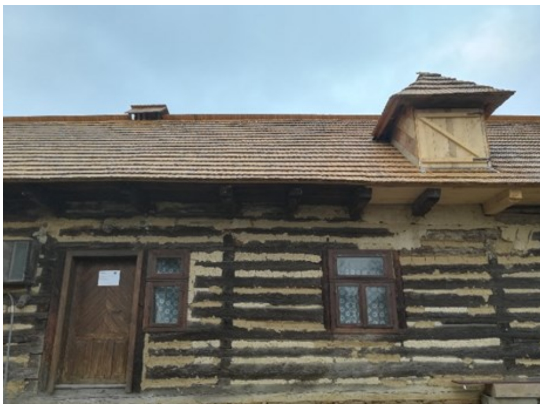
Foto č. 6 Ľudový dom (NKP) po výmene strešnej konštrukcie a statiky
