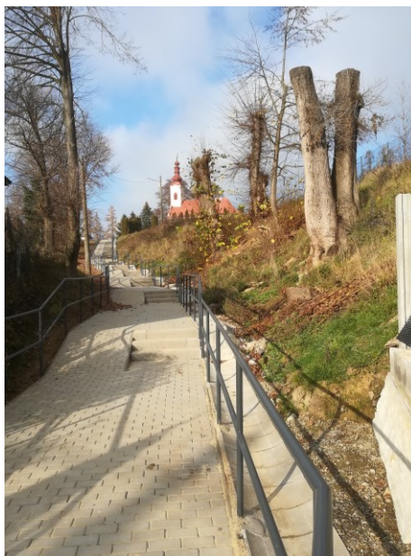
Foto č. 5 Novovybudovaný prístupový chodník ku kostolu
