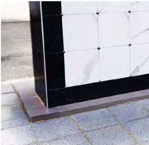
Ukážka prekrytia základov nalepením obkladu z dôvodu nerovností pri betonáži.
