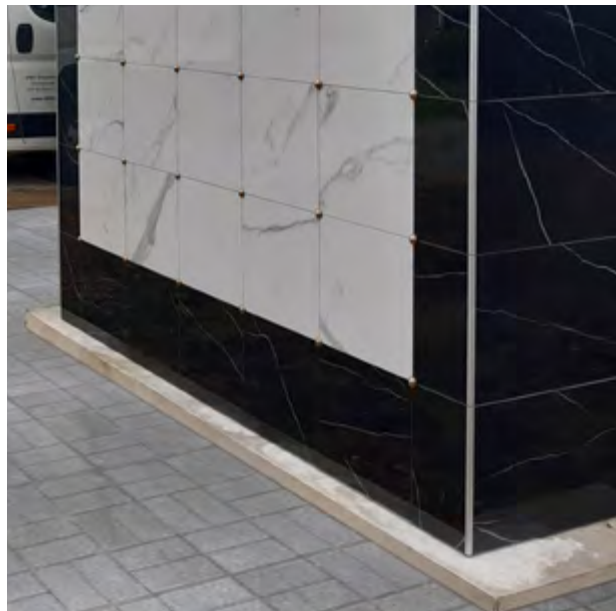
Precízne pripravené základy nepotrebujú následné prekrytie nerovností. Je len na zákazníkovi, či chce betón ponechať pohľadový, alebo vzhľad doplniť prekrytím.
